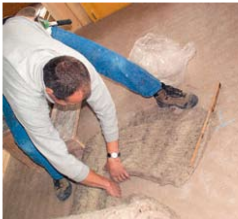
Schafwoll-Dämmstoffe können von Hand zugerissen werden und lassen sich angenehm verarbeiten. (Fotos: mo)
