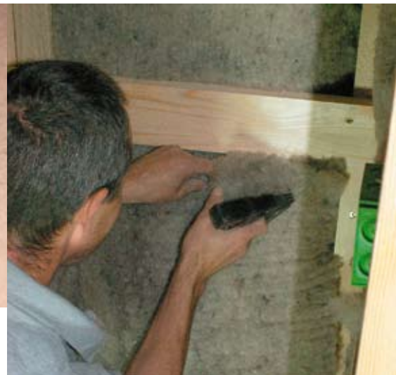
Schafwoll-Dämmstoffe können von Hand zugerissen werden und lassen sich angenehm verarbeiten. (Fotos: mo)
