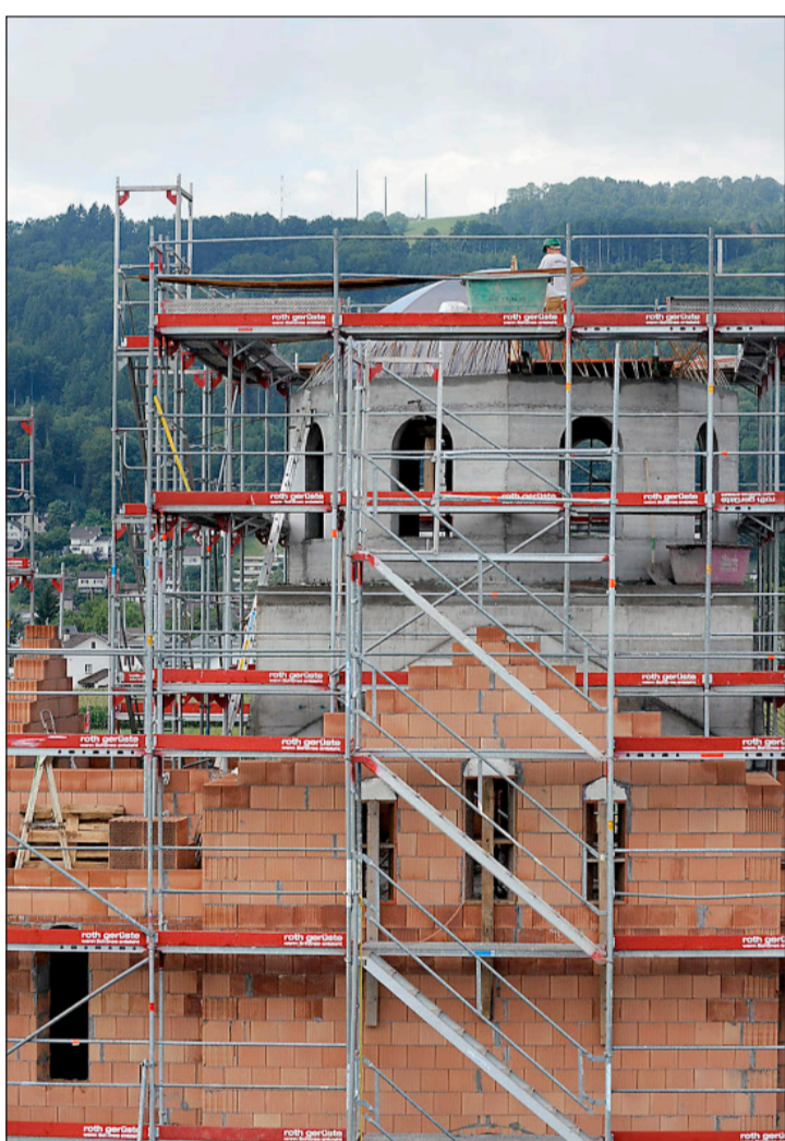
Arbeit in luftiger Höhe beim Kuppelbau. Susanne Keller
